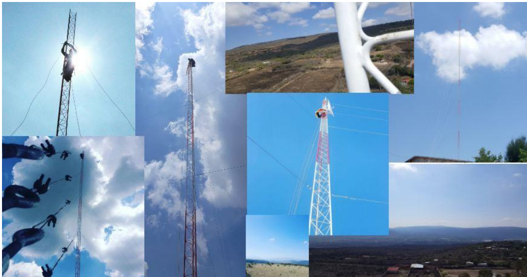
Figura 6 Imágenes del montaje de torres y antenas.
