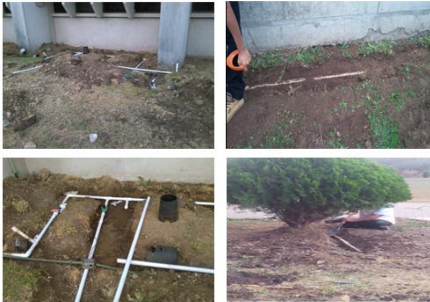
Figura 6 Mantenimiento realizado a la tubería hidráulica en la zona 2 y 3.
