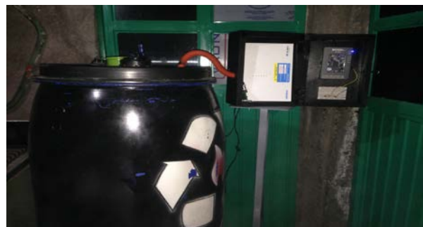
Figura 16 Biodigestor terminado de manera física.
