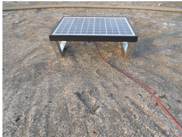
Figura 13 Prueba de panel fijo a la intemperie.
