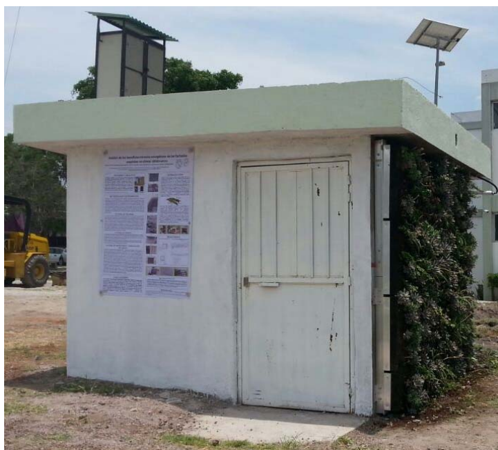
Fig. 1. Vista lateral de la caseta con fachada verde.
