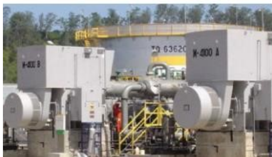
Figura 12 Motores síncronos SEF900 (Ex-p) 3600 kW, 13200 V. Aplicación: Compresores Recíprocos (Petroquímica).
