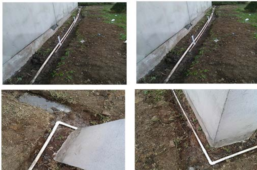
Figura 5 Mantenimiento realizado a la tubería hidráulica en la zona 1.
