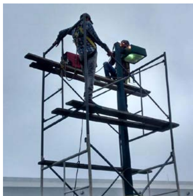
Figura 7 Desmontaje de lámpara.
