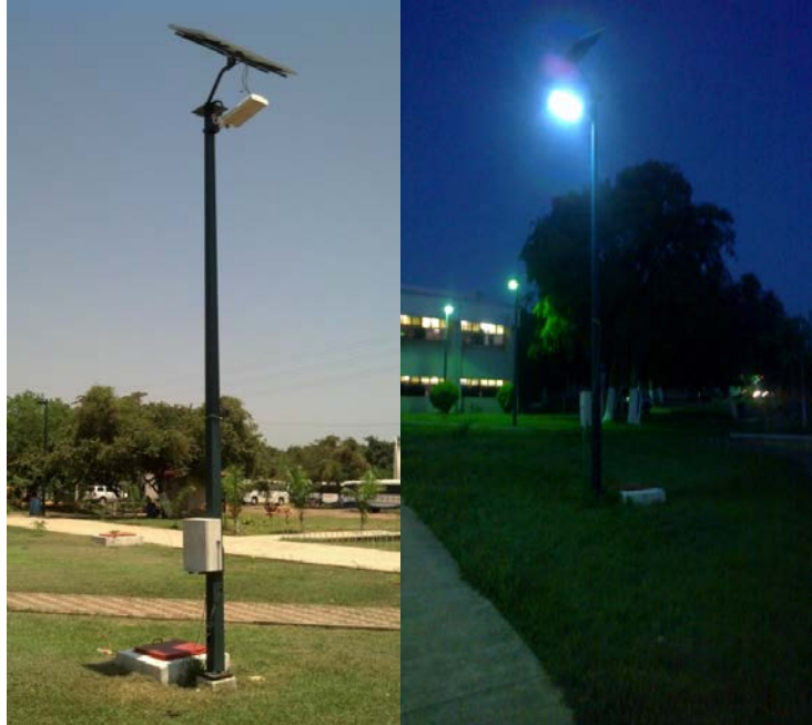
Figura 14 Instalación final del panel solar en la UT de Altamira.
