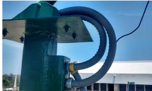
Figura 6 Montaje de placa para soporte de panel solar.
