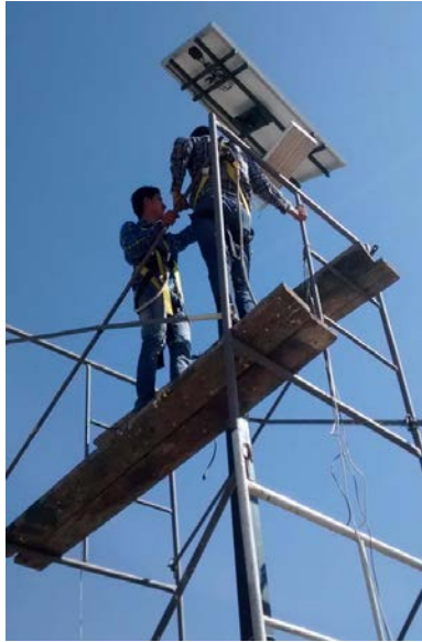
Figura 8 Montaje del panel fotovoltaico.
