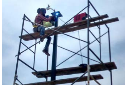
Figura 5 Soldado de placa para soporte de panel solar.
