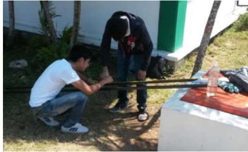
Figura 2 Medición de los tramos de PTR, para realizar el soporte del panel solar.
