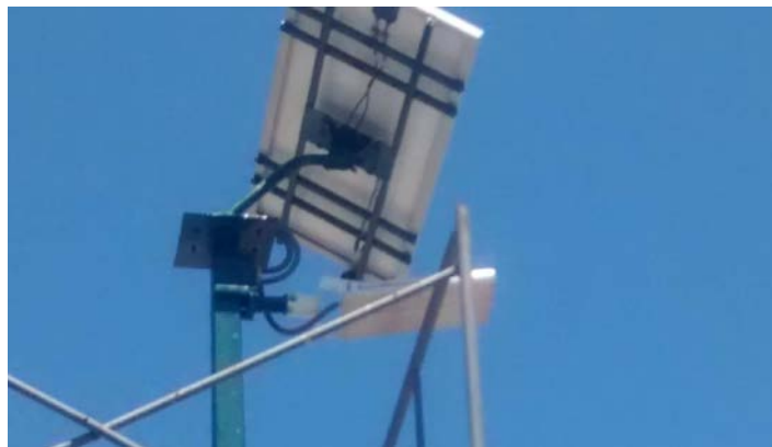
Figura 9 Instalación de lámpara tipo Led.
