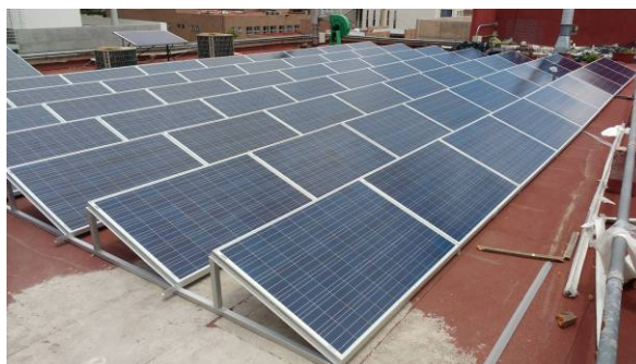
Figura 12 Montaje de los paneles solares.
