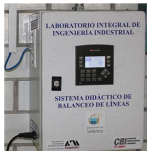
Figura 12 Vista de uno de los tableros construidos.
