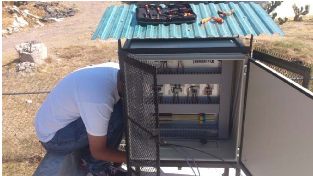
Fig. 14. Instalación de los gabinetes con los tableros construidos.
