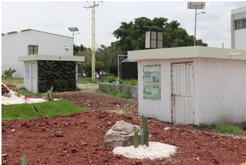
Fig. 3. Vista lateral de la caseta con muro verde y caseta testigo.
