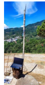
b) Transmisor instalado en PB.
