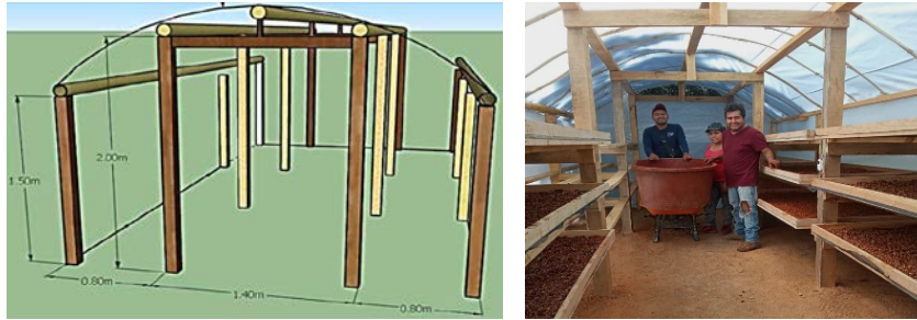
Figura 1 Diseño y construcción del secador solar en Zaragoza Itundujia, Oaxaca.
