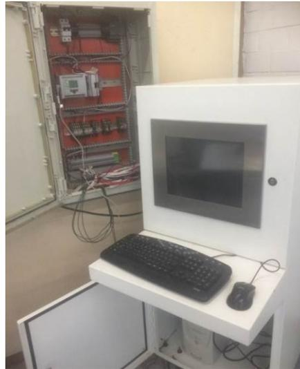
Figura 10 Consola de operación y tablero de control con PLC.
