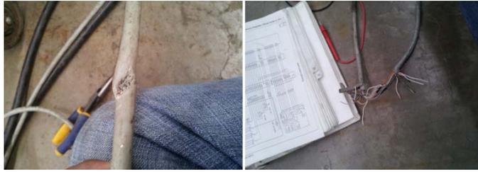
**Fig. 4. Cables dañados.**
