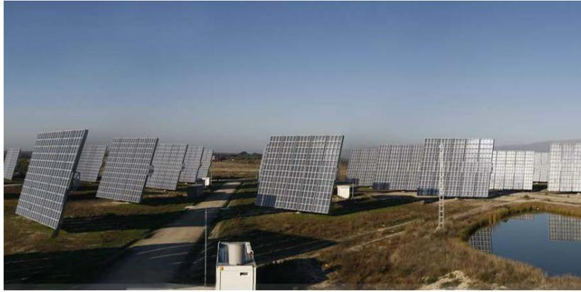
**Fig. 1. Existencia de sombras en los campos fotovoltaicos de alta concentración.**
