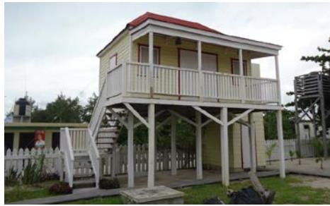
Figura 3 Vivienda sobre pilotes y plataforma de elevación.
