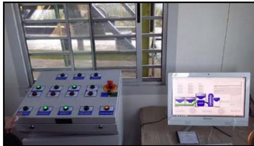
Figura 16 Cabina de control, botonera para control manual y HMI SCADA desarrollado.
