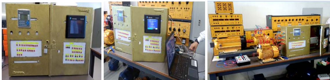
Figura 21 Construcción de equipo OPC de paro y arranque de motor trifásico.
