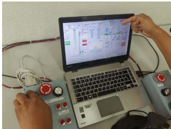
Figura 11 Operación de las bombas.
