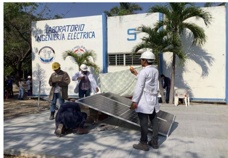
Figura 1 Panel fotovoltaico SRP-450-BMA-HV instalado.
