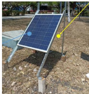
Figura 1 Panel fotovoltaico PRO8512 instalado con ángulo de inclinación de 44^\circ .
