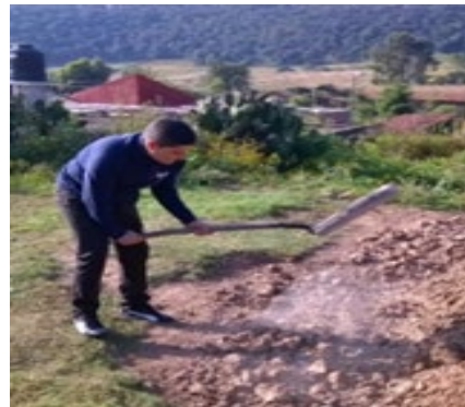
Figura 2 Triturado la tierra con un apaleador.
