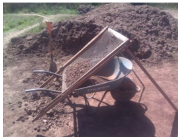
Figura 3 Harneo de la tierra después de ser triturada.
