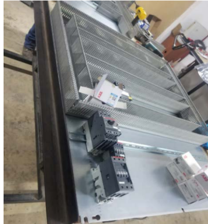
Figura 8 Colocación de canaletas y el riel din.
