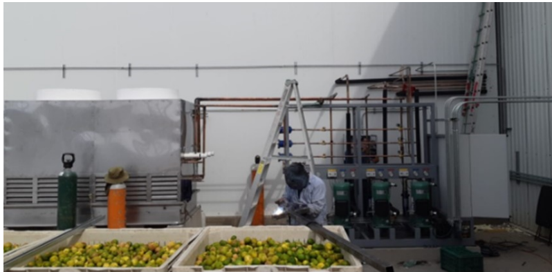
Figura 16 Instalación en campo de tablero de fuerza y control.
