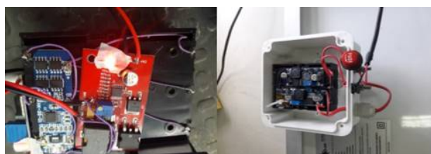
Figura 16 Montaje e instalación básico de la topología de conexión seleccionada.
