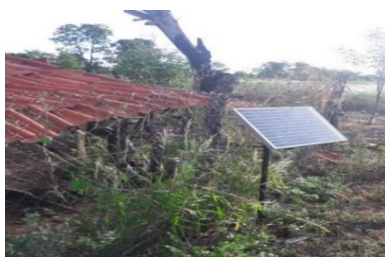
Figura 17 Instalación del sistema en la comunidad de Tiberia.
