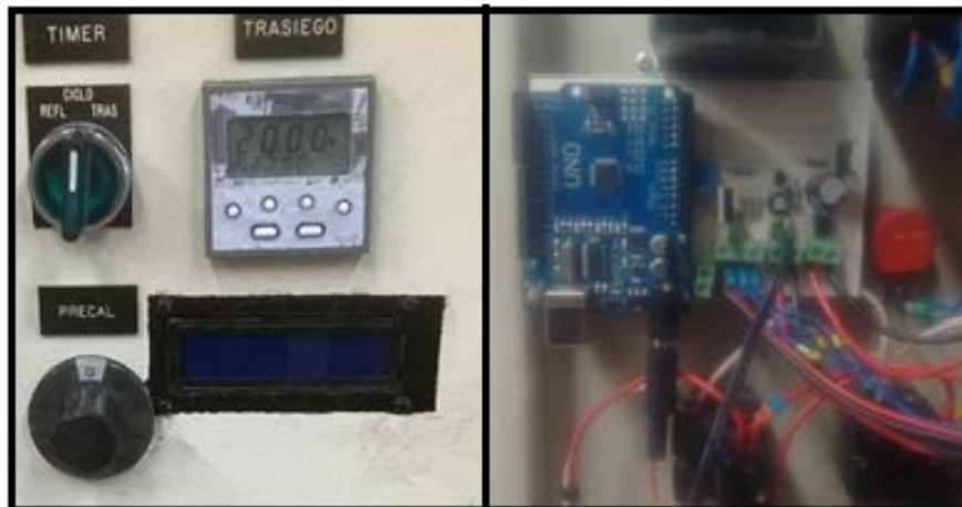
Figura 13 Instalación de tarjeta de control.
